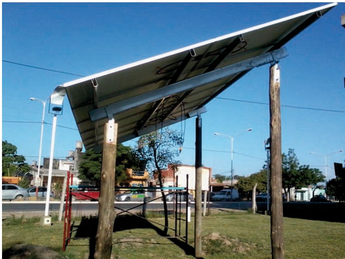
Figura 7. Fotografía de la cubierta solar en su proceso constructivo
