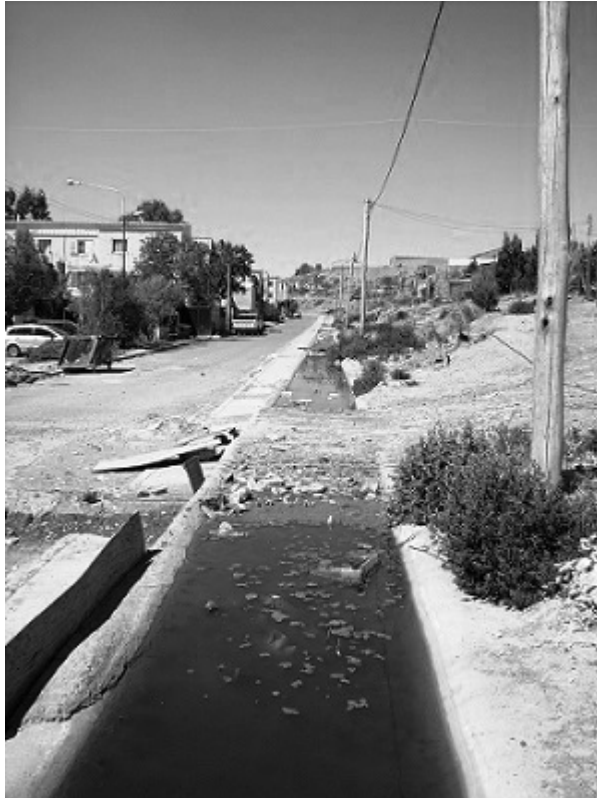
Imagen 2. Situación posterior a la intervención pública municipal. Enero de 2013 Fuente: propia
