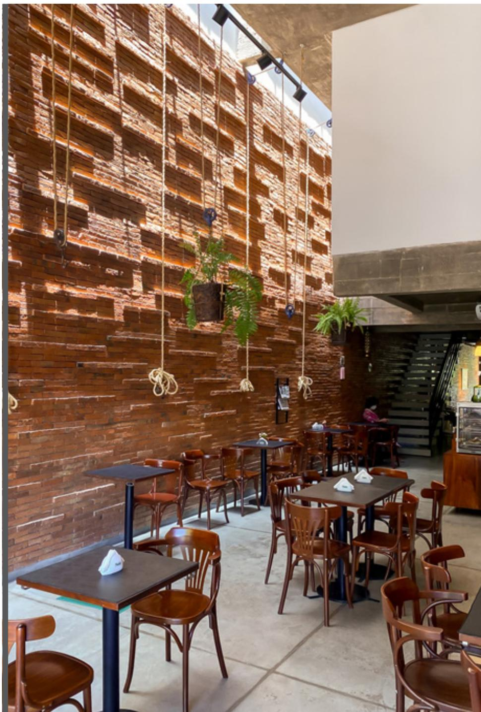
Además, se implementaron estrategias bioclimáticas, como el uso de doble muro con aislamiento térmico en las envolventes y parasoles en la fachada oeste para reducir el impacto solar. En la cubierta, se instaló un deck de madera para crear sombra sobre la cubierta plana del restobar en la planta baja. Para maximizar la iluminación natural, se diseñó una abertura cenital en la medianera sur que incluye una chimenea solar para mantener una ventilación natural continua del espacio (figura 4).
