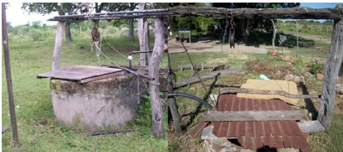
Figura 2: Imágenes de pozos excavados (fotos tomadas por el equipo de trabajo).
