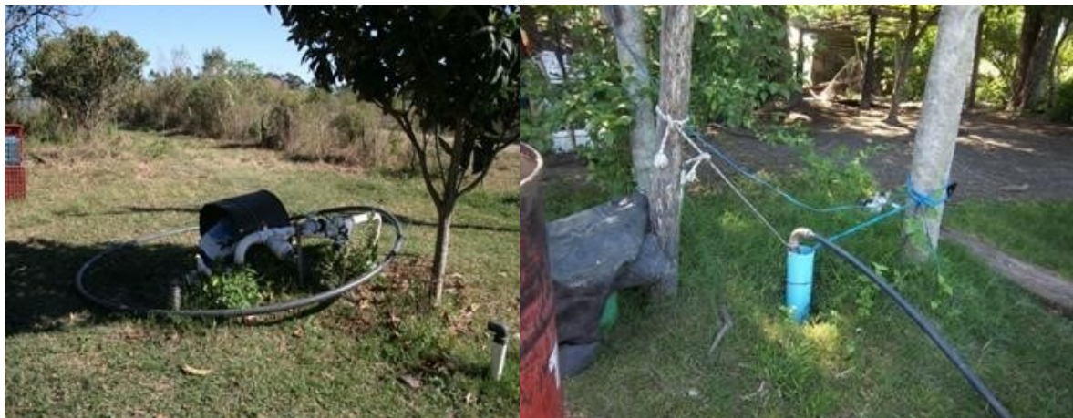
Figura 1: Imágenes de perforaciones (fotos tomadas por el equipo de trabajo).
