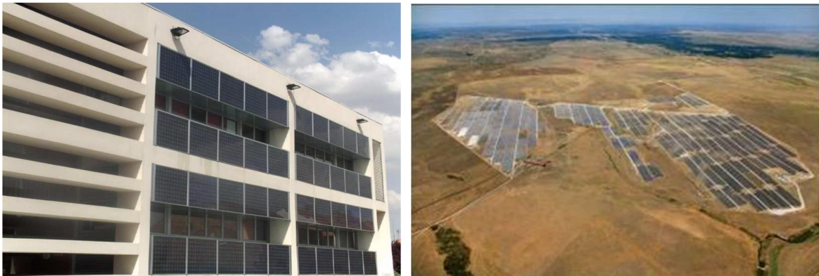
Figura N° 2: sistemas interconectados a Red, PV in buildings en el Centro Cívico “el Cerro” (Coslada-Madrid) y las Centrales de Potencia. Trujillo, Extremadura, Spain-Elecnor. Fuente: www.iresud.com.ar
