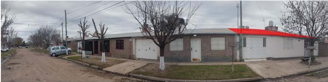
Fig. 3. Sitio de Ubicación de los colectores solares planos
