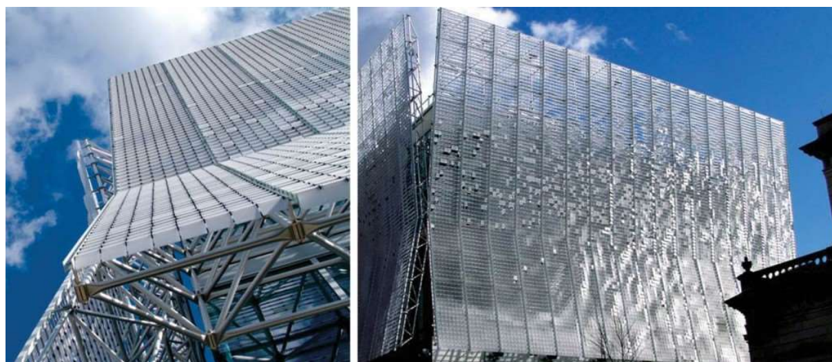
Fig. 8: Módulos de chapa que se mueven con el viento en children's museum Pittsburgh
