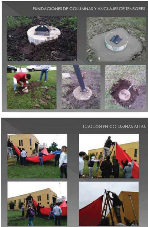
Figura 3y4: Fundaciones de columnas, anclajes de tensores y fijación de columnas. Fuente: Proyecto de Investigación CIUNT B503 "Didáctica Projectual".
