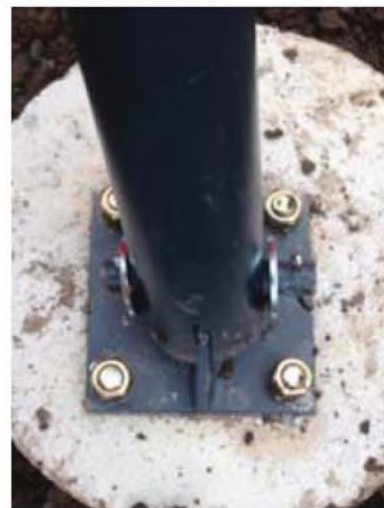
Figura 7: Anclajes de la columna metálica Fuente: elaboración propia
