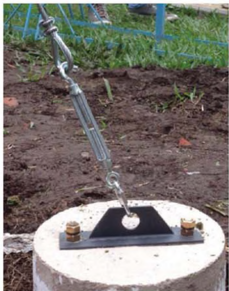
Figura 6: Anclajes de la columna metálica Fuente: elaboración propia
