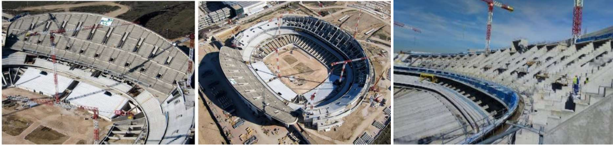
Figura 7: Ampliación de Estructura de Hormigón. Fuente: nuevoestadioatleti.blogspot.com .
