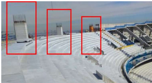
Figura 8: Detalle soportes elevados por sobre el graderío para recibir la cubierta. Fuente: nuevoestadioatleti.blogspot.com
