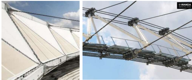
Fig. 20: Anclajes de tensores en celosía y biela (cabezal industrial). Fuente: atleticodemadrid.com/galerias
