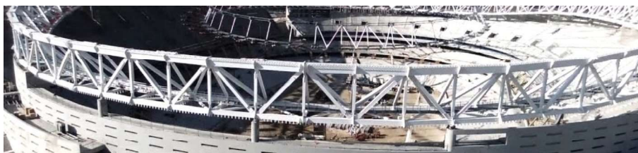
Fig. 19: Cercha de acero. Anillo de Compresión. Fuente: nuevoestadioatleti.blogspot.com/p/en-construcción
