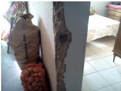
Figura 7 **apertura de muro – armadura expuesta**
