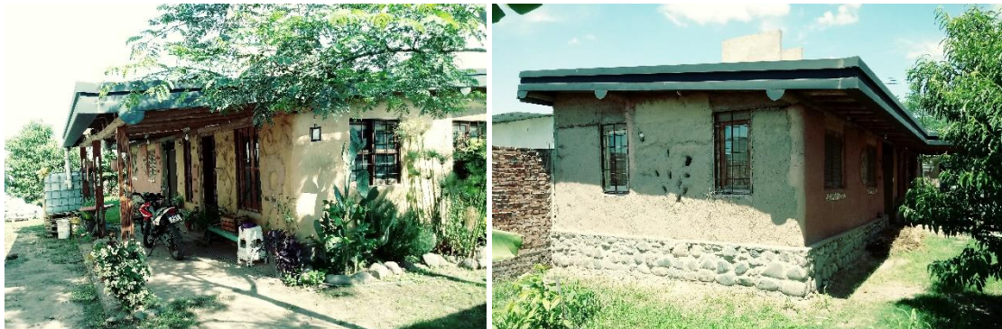
Figura 2. Imágenes del frente y contrafrente de la vivienda durante el monitoreo de verano. Fuente: elaboración propia.
