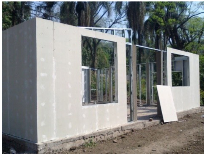
Figura 9. Las juntas exteriores se sellaron con masilla de alta flexibilidad Foto de los autores.
