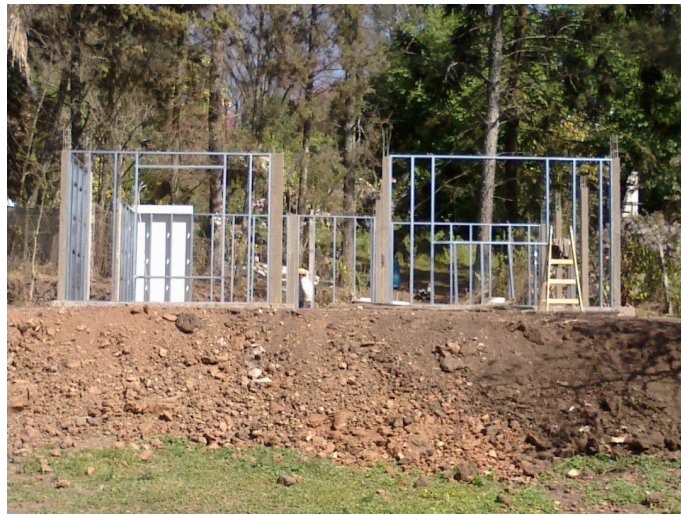
Figura 5. Etapa Inicial. Construcción de la platea, columnas estructurales, soleras y montantes Foto de los autores
