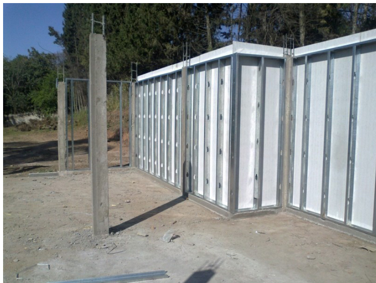
Figura 8. Estructura a base de soleras inferior y superior, montantes, con una separación de 45 cms y cierre con placa cementicia al exterior Foto de los autores.
