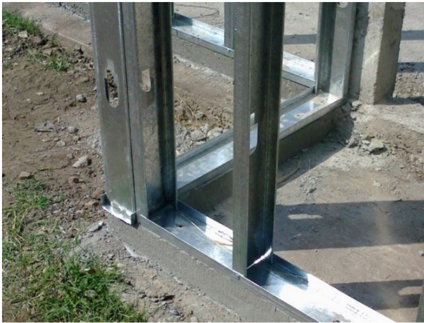
Figura 7. Fijación de montantes y soleras a cordón de H°A° Foto de los autores
