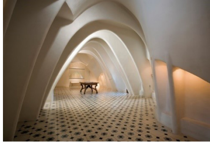
Figura 18 Arcos Catenarios en el ático de la casa Batlló
