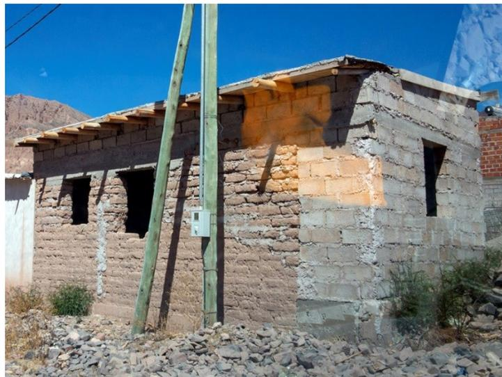
Figura 5. Vivienda en construcción con utilización de materiales tradicionales e industrializados
