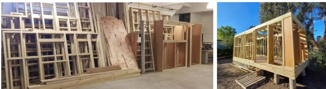
Fig. 3. Prefabricación y Estructura montada PB. Fuente propia
