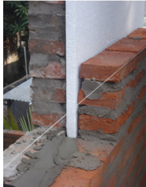
Fig. 20. Aislación térmica paredes
