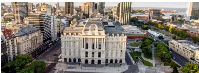
Figura 1. Vista del CCK. Fuente: gobierno de la ciudad de Buenos Aires.
