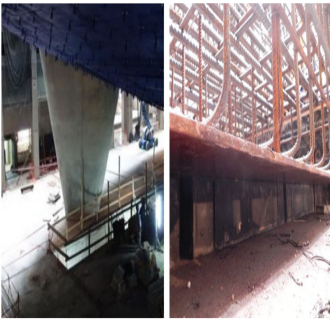
Figura 5 (izq). Muestra las almohadillas de goma sobre las que se montan las columnas. Fuente: Basso (2021).
