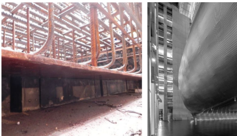
Figura 5 (izq). Muestra las almohadillas de goma sobre las que se montan las columnas.
