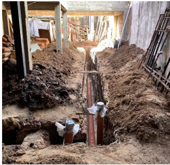
Figura 4: instalación de las tuberías de intercambio en vivienda entre medianeras de la ciudad de Santa Fe. Fuente: Registro fotográfico Arq. Sebastián Puig.
