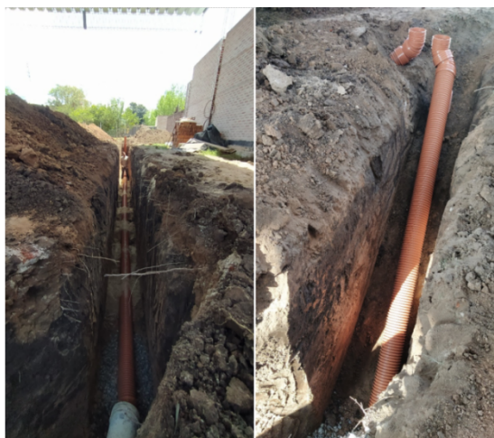
Figuras 5 y 6: Instalación de las tuberías de intercambio en gimnasio de la ciudad de Humboldt. Provincia de Santa Fe. Fuente: Registro fotográfico Arq. Gabriel Kröling.
