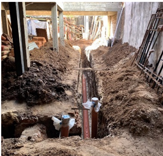
Figura 4: instalación de las tuberías de intercambio en vivienda entre medianeras de la ciudad de Santa Fe.
