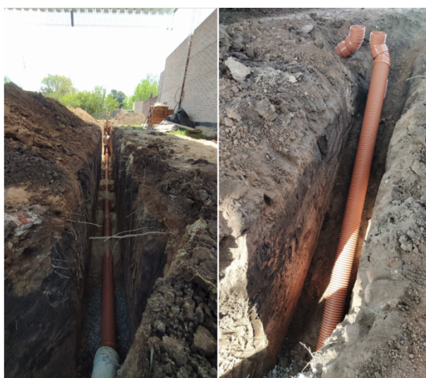
Figuras 5 y 6: Instalación de las tuberías de intercambio en gimnasio de la ciudad de Humboldt. Provincia de Santa Fe.
