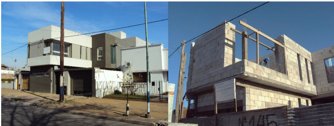
Figura 5: Casa en Tolosa. Inserción urbana y foto obra sistema HCCA.
