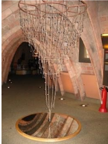
Fig. 6: Modelo colgante con pesos colocados estratégicamente para diseñar la Sagrada Familia.
