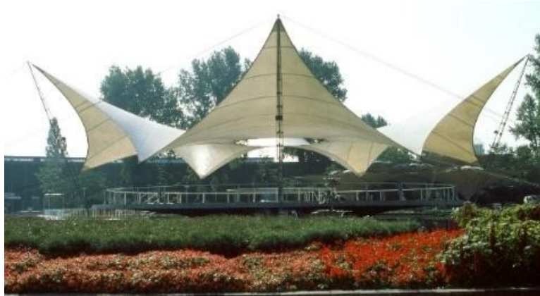
Fig. 10: La "Tanzbrunnen", cubierta minimal diseñada por Frei Otto (Colonia 1957).
