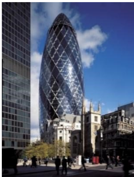
Fig. 9: Edificio 30 St Mary Axe.
