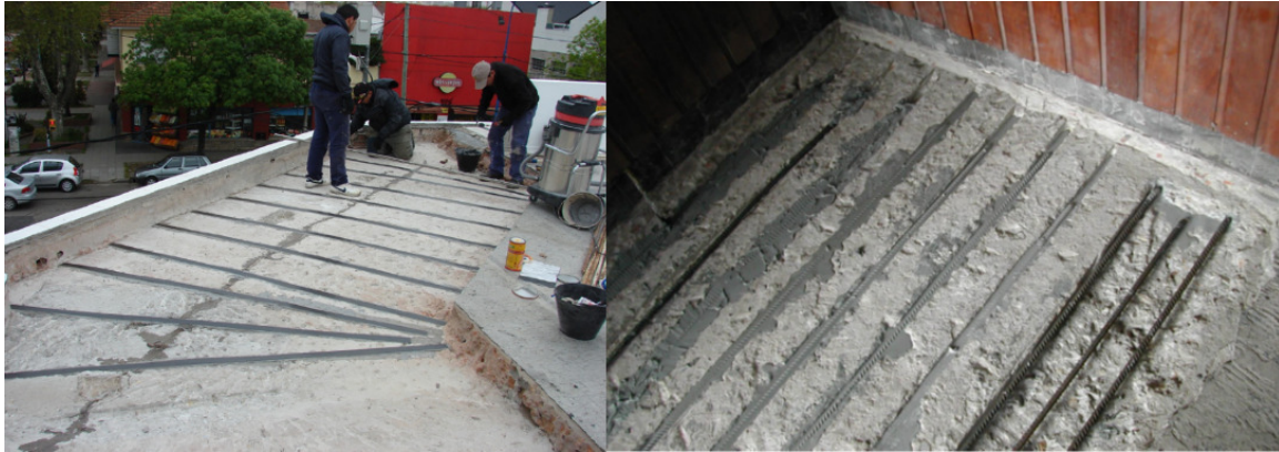
Figura 9. A la izquierda bandas de fibra de carbono. A la derecha agregado de armadura superior. Fuente: Estudio Médicos de Edificios.
