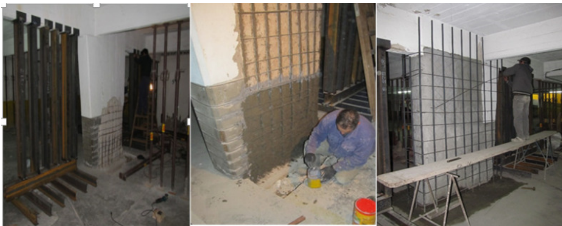
Figura 10. A la izquierda apuntalamiento. Al centro y derecha: zunchado de columna con recrido de hormigón. Fuente: elaboración propia.
