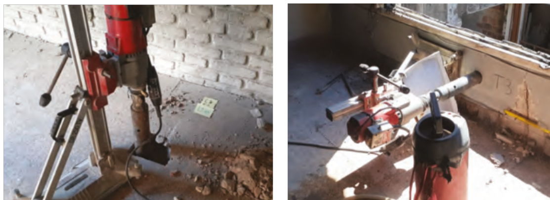
Figura 3. IZQUIERDA y derecha: herramienta para la extracción de testigos.
