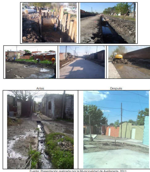
Figura 2. Obras de infraestructura en Villa Tranquila realizadas en el marco del PROMEBA: redes pluviales y apertura de calles.
