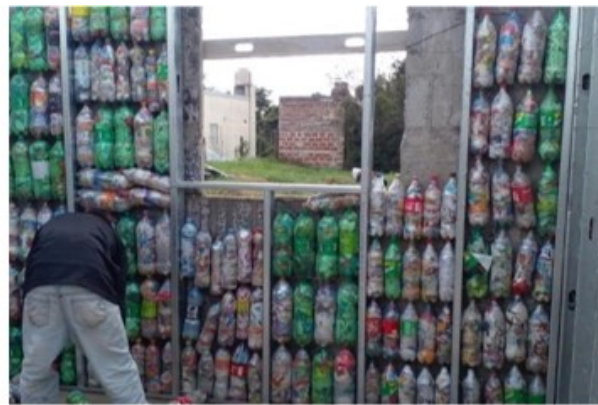
Figuras 12 y 13 Vista interior de los muros de PET, previo a la incorporación del material aislante Relevamiento propio, 2025
