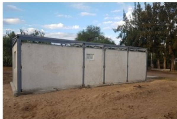
Figuras 10 y 11 Montaje y vista de los paneles de hormigón armado y estructura de cubierta en VU-P.H°A° Relevamiento propio, 2022
