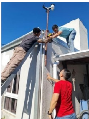
Figura 6: Instalación de Estación Meteorológica en VU-Steel. Fuente: Relevamiento propio, 2026.
