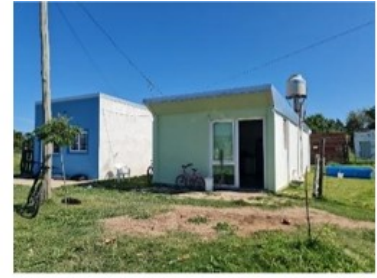
Figura 4: Vivienda de Paneles Modulados PET. Fuente: Relevamiento propio, 2026.
