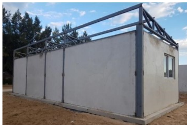
Figuras 10 y 11 Montaje y vista de los paneles de hormigón armado y estructura de cubierta en VU-P.H°A° Relevamiento propio, 2022
