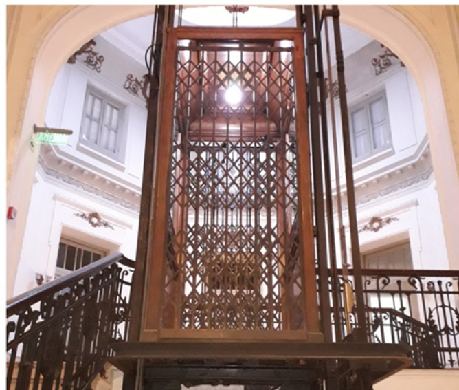
Fig. 26, 27 y 28: Diversos ángulos y recorridos del centenario ascensor Roux Combaluzier en el Petit Hotel.
