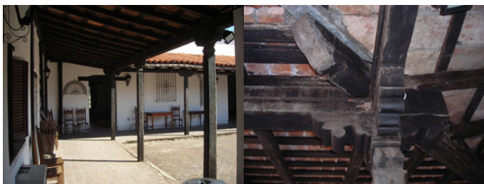
Figura N° 7. Galería interior y detalle zapatas lobuladas -madera- de Casa Mecca / Casa Martínez. Sector de galería, capitel de madera torneado. Imagen de Año 2023. (Fotos Salas, MP. - Piñeiro E., 2023)
