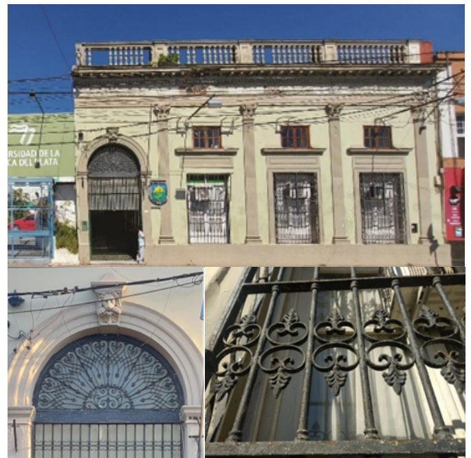
Figura N° 11. Detalles casona sobre Plácido Martínez. Rejas de hierro fundido con ornato tipo ancla. Pilastras estriadas, capiteles corintios. Balaustre de columnatas de cemento. Acceso remarcado por reja de medio con batiente tipo abanico, clave de ornato zoomorfo (Fotos: Salas P. 2023)
