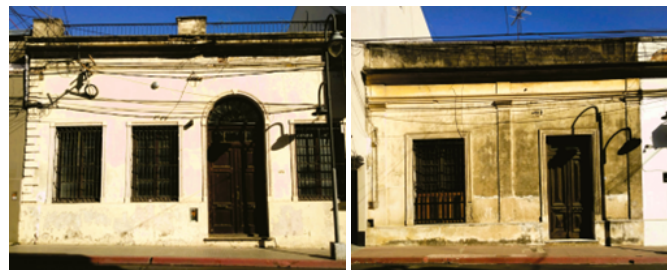
Fig. 5. Detalle casas sobre bajada calle La Rioja. Izq.: Pretil metálico y puerta con dintel de medio punto y batiente tipo abanico, molduras con saledizo rectilíneo. Pilastras almohadilladas / Der. Remate liso, pilastras lisas y molduras. Puerta y ventanas con dintel recto –sector de fachada-(Fotos: Salas P. 2023)
