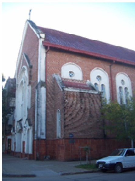
Imagen 18: Fachada Lateral. Parroquia María Auxiliadora. Año 2008.
