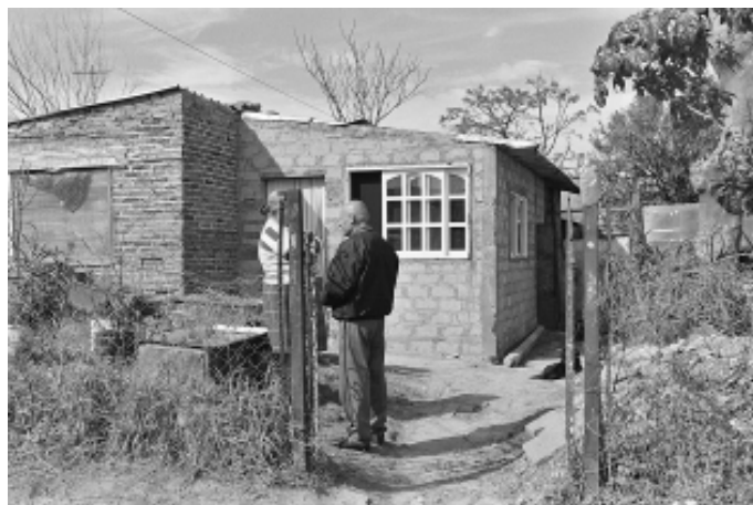
Figura 5: Paredes exteriores de ladrillo y bloque sin revocos Fuente: Rodolfo Rotondaro
