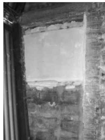
Figura 6: Pared interior de ladrillo común Fuente: Rodolfo Rotondaro
