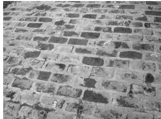
Figura 4: Piso de ladrillos de plano Fuente: Rodolfo Rotondaro
