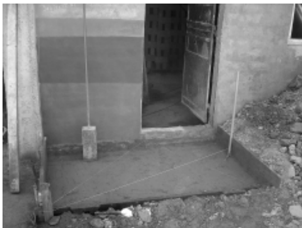
Figura 11: Contrapiso de suelo estabilizado compactado Fuente: Rodolfo Rotondaro
