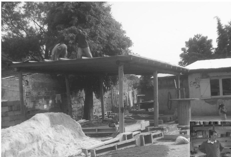
Foto 1. Construcción del galpón Fuente: equipo de investigación
