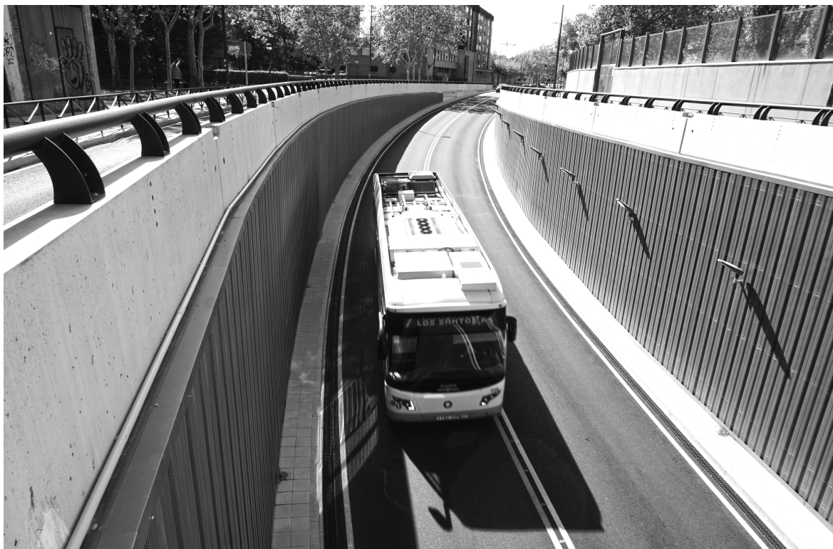
Figura 7. Paso inferior, rodado y peatonal, entre calles de la Noche Vieja y Andrómeda, ejecutado (registro propio, mayo de 2022)
