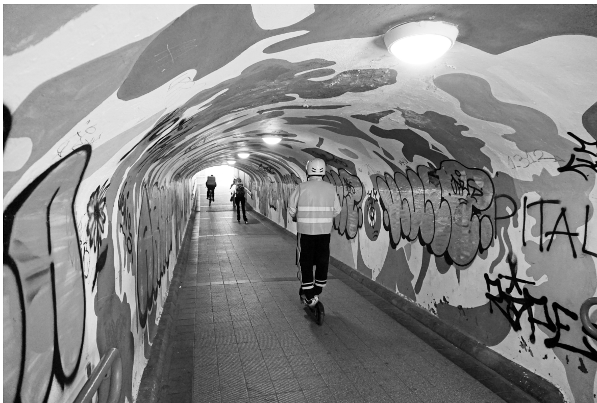
Figura 3. Paso inferior peatonal en calle de Labradores (registro propio, mayo de 2022)
