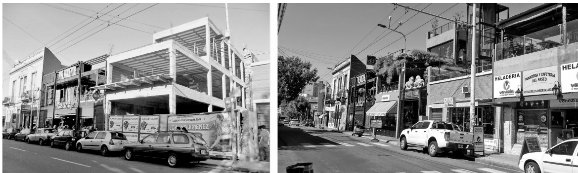
Figura 3. Renovación edilicia en calle Belgrano al 700, del Barrio Güemes. Elaboración propia, 2015, 2017
