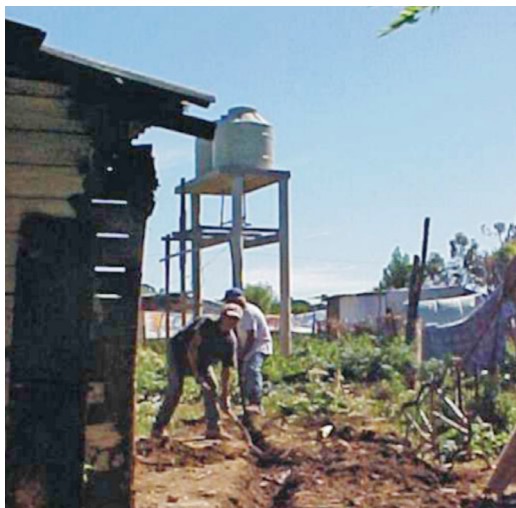
b. Tendido de cañería
