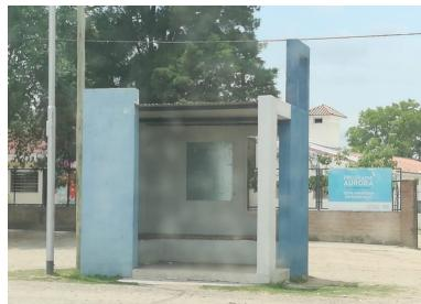
Figura 10. Punto Limpio de recolección de reciclables en Juárez Celman. Figura 11. Capacitación para equipo técnico de Juárez Celman. Figura 12. Garita para ómnibus en Juárez Celman, con ladrillos PET. Fuente: Archivo fotográfico del instituto.
