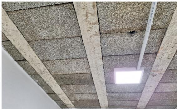
**Figura 9.** Bloques de losa con plástico reciclado en Arroyito.
