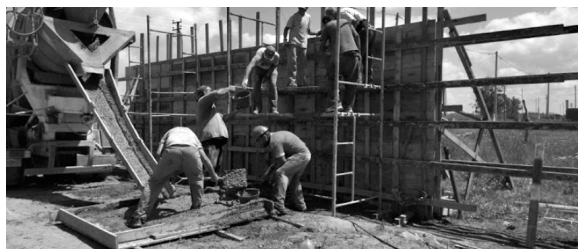
Figura 8 Proceso constructivo de la plaza: encofrado, hormigonado y montaje del semicubierta.
