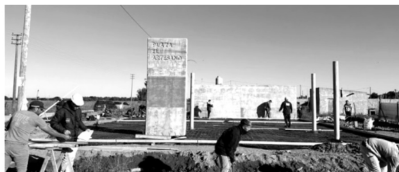
Figura 8 Proceso constructivo de la plaza: encofrado, hormigonado y montaje del semicubierta.
