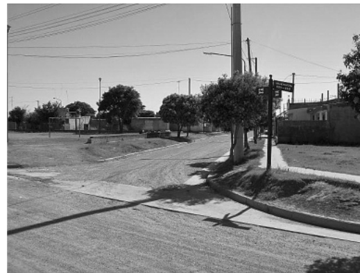
PROMEBA. Obras públicas: alumbrado público, vereda y cordón cuneta
