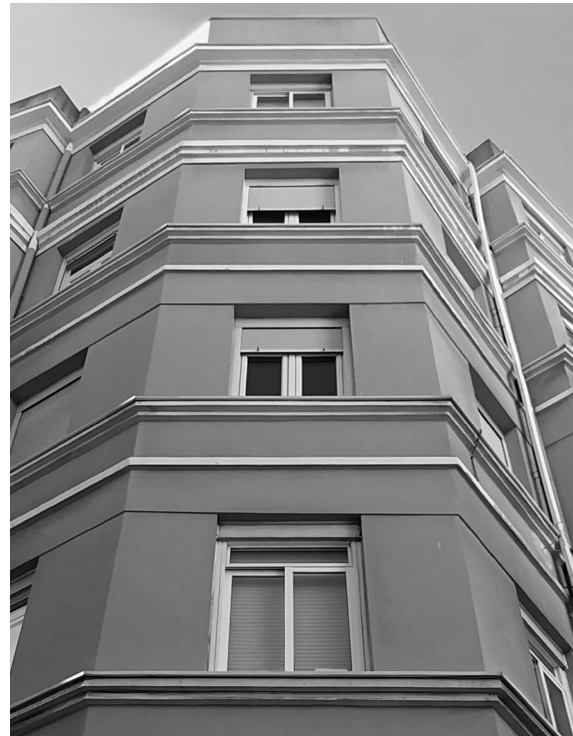
Figura 4 Rúa Falperra, 78. A Coruña (2025)
