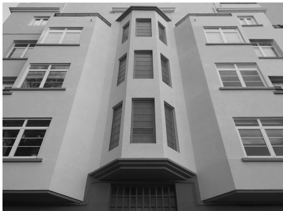
Figura 8 Avenida Fisterra, 95. A Coruña (2025)
