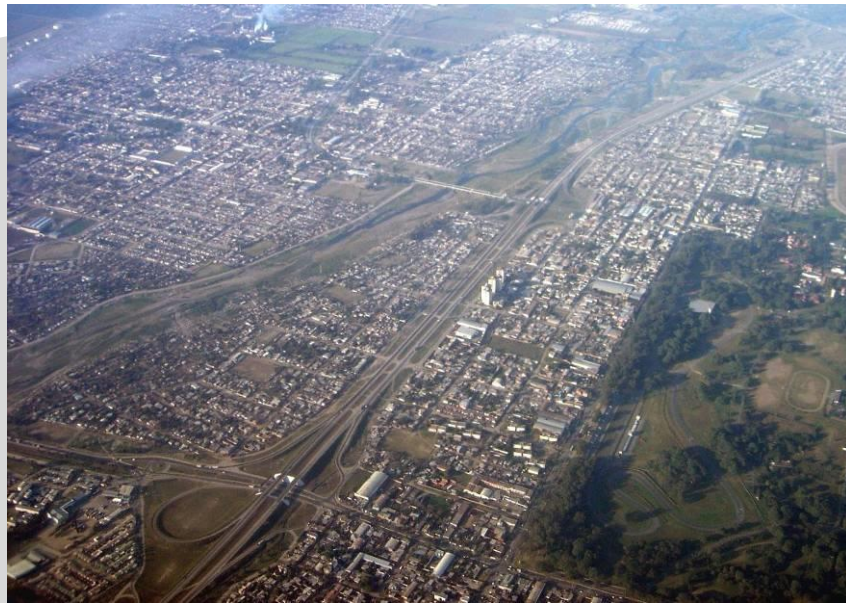
Figura 3: Vista área de avenida de Circunvalación
