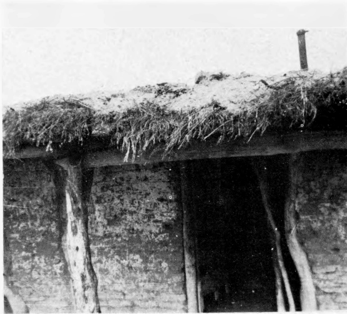
Fig. 2. Vista exterior del techo de la vivienda.
