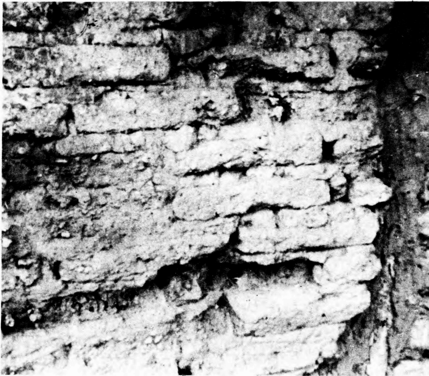
Fig. 1. Detalle de las paredes internas de la vivienda.
