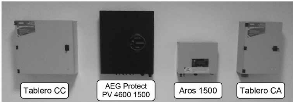
Figura 3 – Instalación de tableros de maniobras e inversores.
