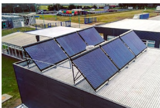
Figura 3 a) Instalación terminada
