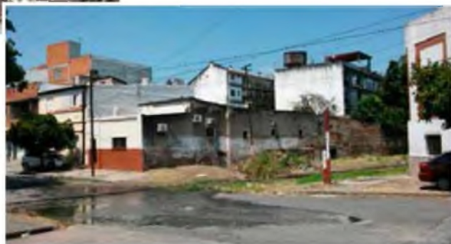
Figura 10. Aguas servidas superficiales en la intersección de las vías con calle Marcos Paz (*)
