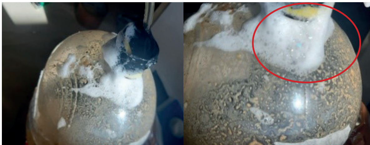
Figura 14. Pérdida de gas que se comprueba por la formación de burbujas utilizando detergente.
