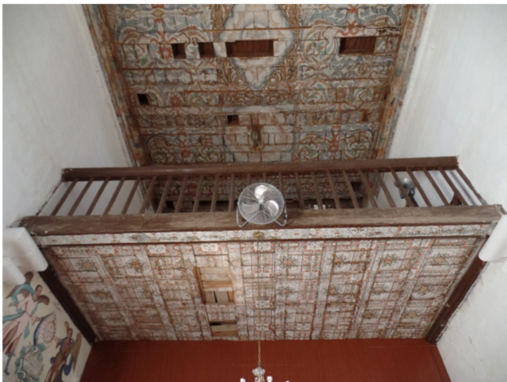
Vista del envigado y techo del sotocoro. A la izquierda se distingue la decoración de la entrada al baptisterio. 2015.
