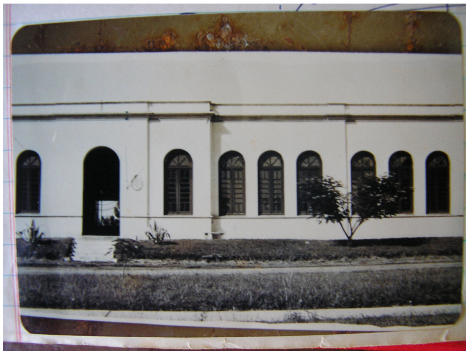
Figura 3: Antigua fotografía de la fachada del Colegio Maipú antes de su demolición (Libro del Colegio Maipú, 1968- 1969)
