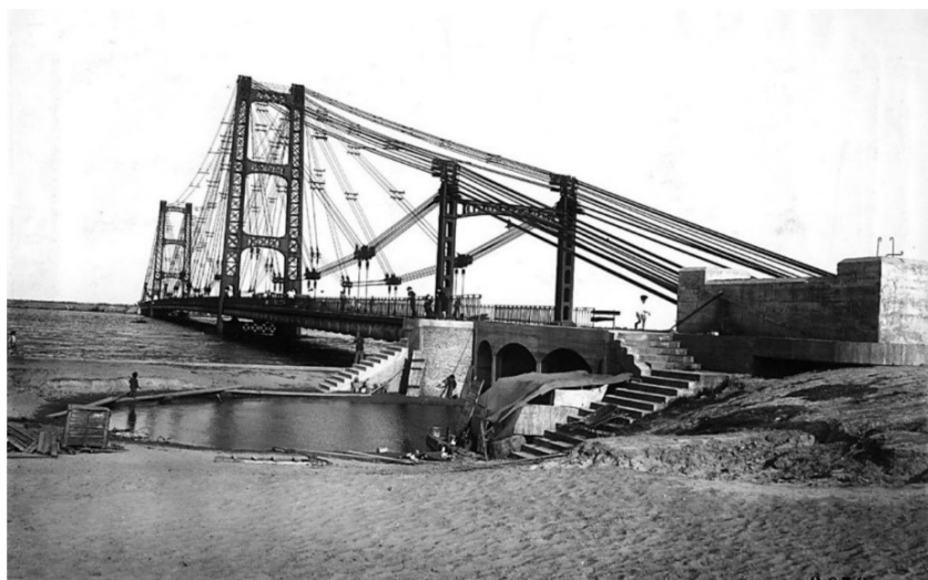
Figura 5. Vista del Puente Colgante durante la construcción del acceso oeste, 1925
