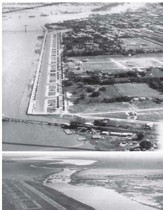
Figura 6. Vista aérea de la Laguna Setúbal durante el breve período en el que convivieron ambos sistemas de transporte. Arriba, Puente Colgante (inaugurado en 1928); abajo, tercer puente ferroviario (1927-1943)
