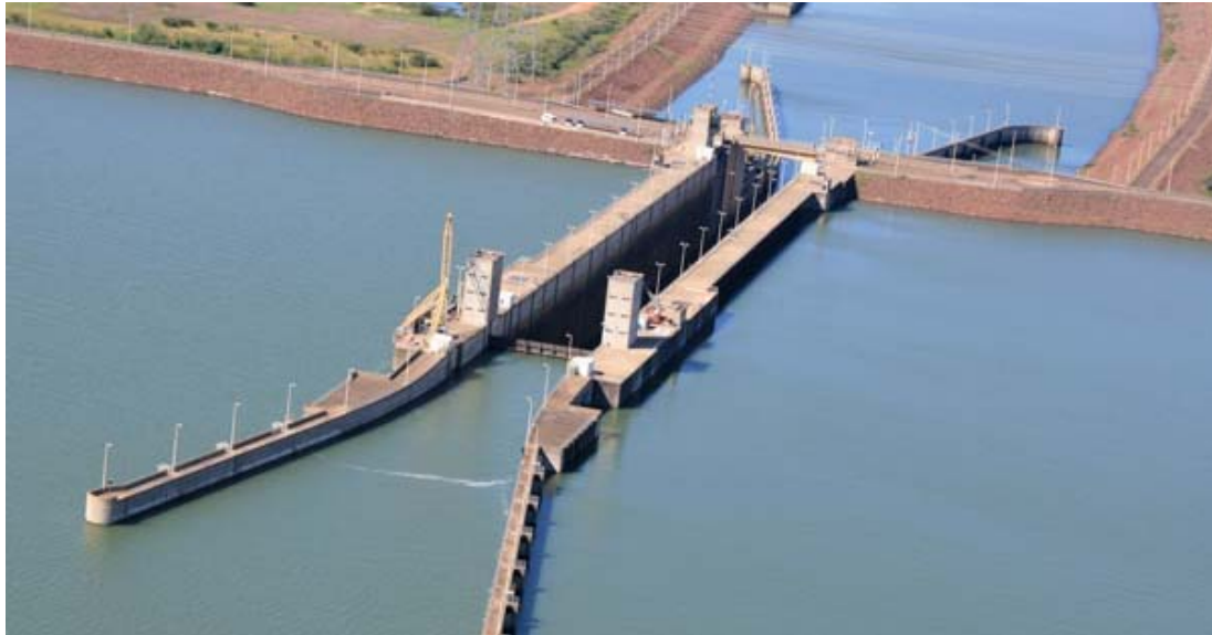
FIGURA 5. Esclusa de navegación de Yacyretá. (Se aprecia el desnivel existente a ambos lados)
