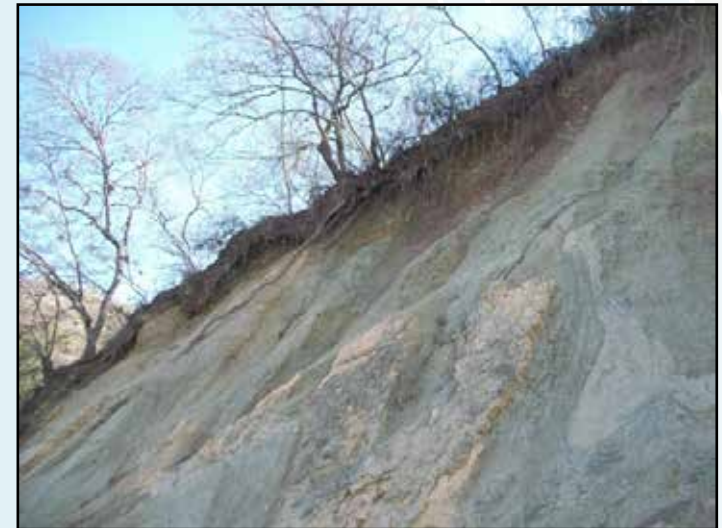
Intercambio iónico en arcillas. Dique Cabra corral - Salta
