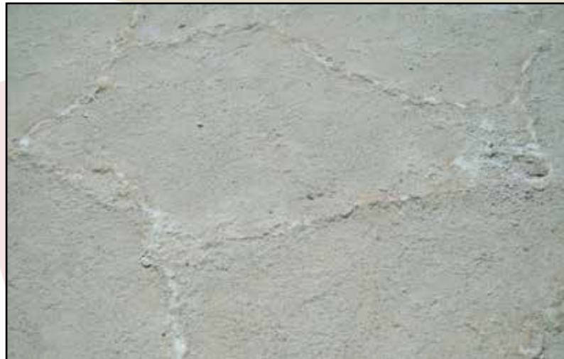
Agrietamiento poligonal en arenas. Salinas grandes - Jujuy
