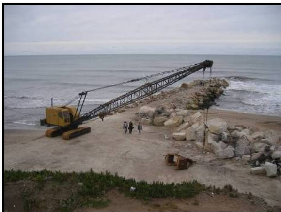
Figura 1. Construcción de la escollera en L, marzo de 2008. Fuente: archivo personal
