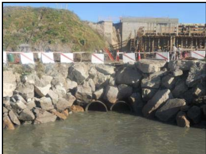
Figura 4. Descarga de la Planta de Tratamiento de Efluentes Cloacales. Fuente: archivo personal. 19/05/2010
