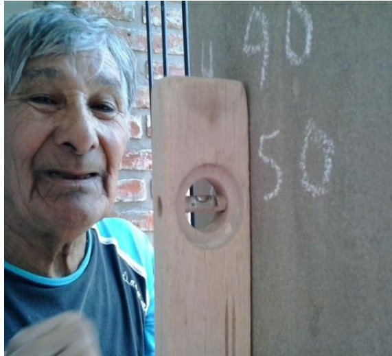
Imagen 4.. Entrevistado A..A. mostrando cómo se utiliza el nivel de mano en la vivienda que constrúa. En la pared pueden observarse los cálculos que sirven de referencia para los albañiles dependientes. Foto tomada en julio de 2014.
